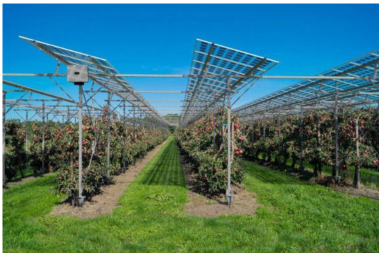
Abb. 6 Lichtdurchlässige PV-Module für den Obstanbau 15
