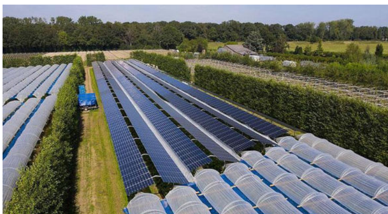
Abb. 5 Agri-PV statt konventionellem Folientunnel (Himbeeranbau) 14
