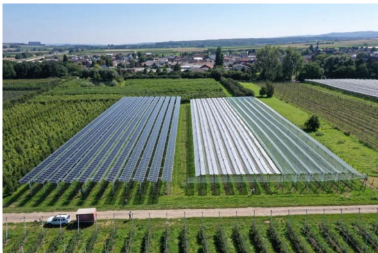
Abb. 4 Photovoltaik-Anlage für Obstplantage in Gelsdorf (Rheinland-Pfalz) 13
