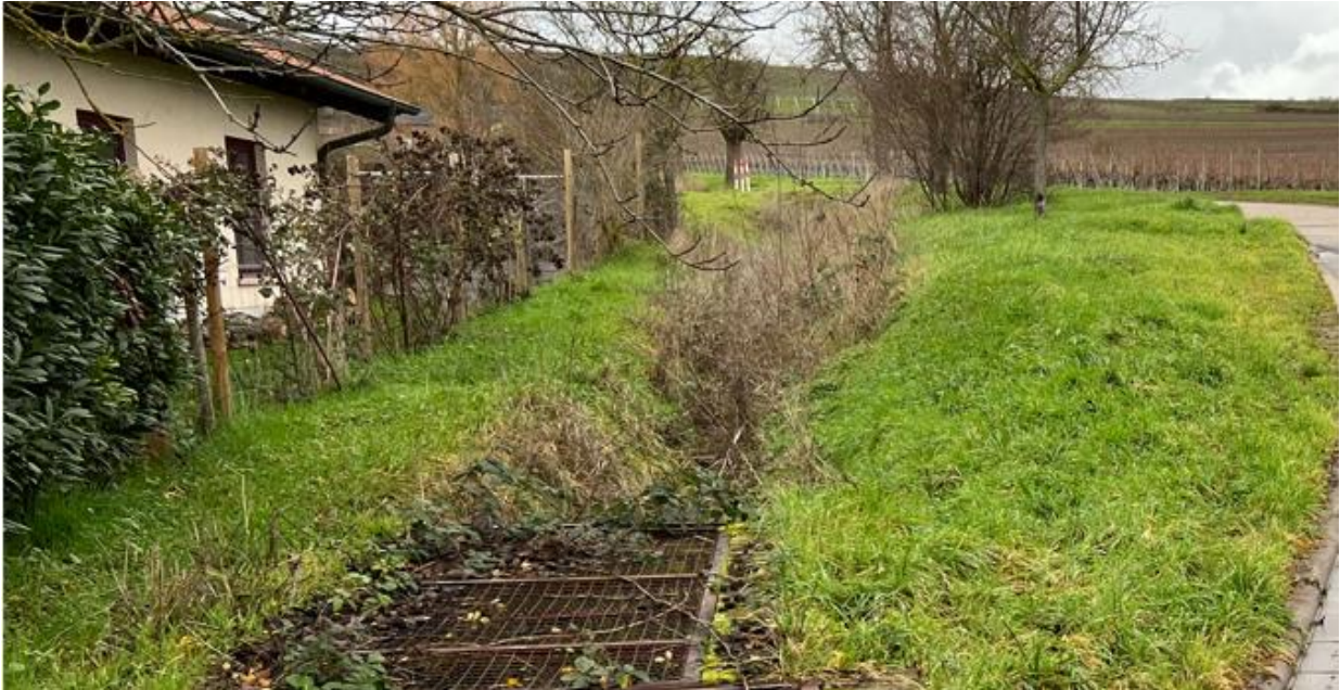
Abb. 137: Stark überflutungsgefährdetes Gebäude am Kützelsborn-Graben unterhalb des unteren Regenrückhaltebeckens
