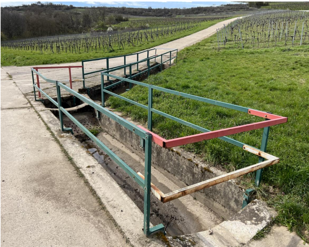
Abb. 278: Betonierte, wasserführende Wege an der Autobahn mit Sandfängen
