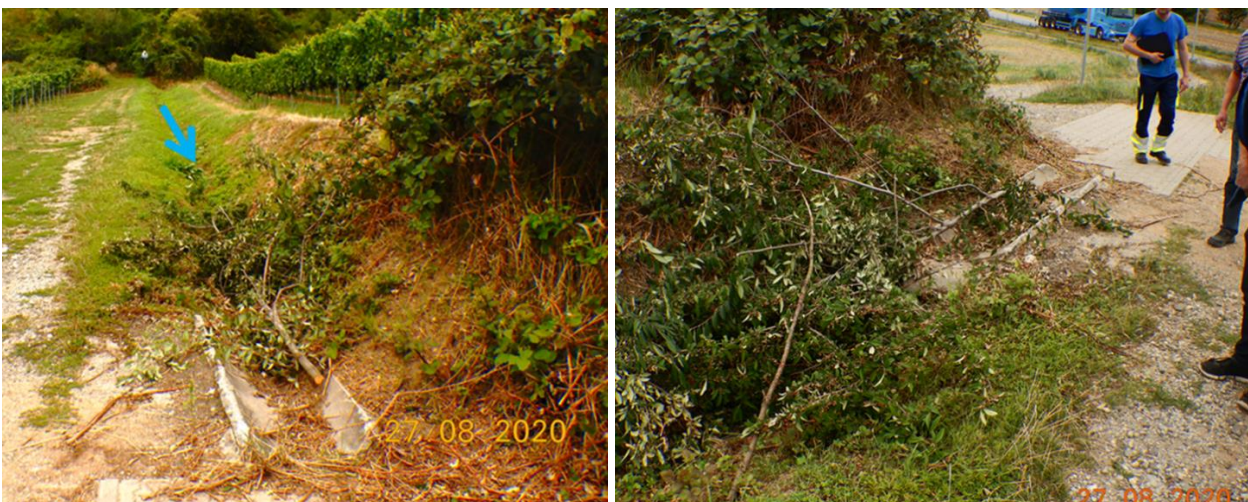
Abb. 43: Betonrinne und Furt im Graben Übelborn unterhalb Grüngürtel Höllenberg
