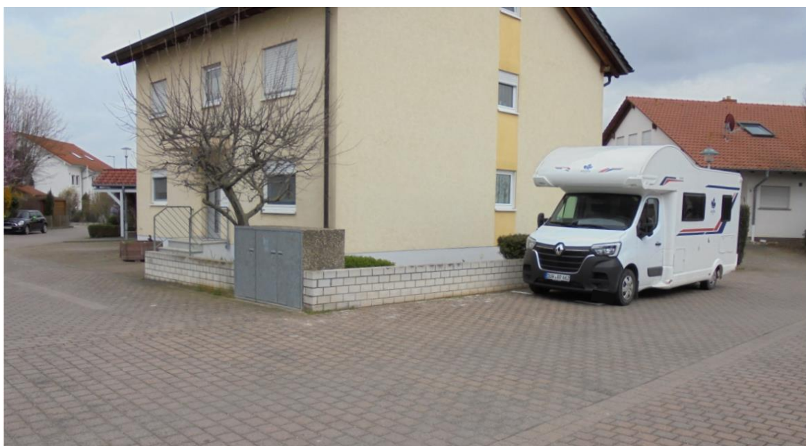
Abb. 323: Überflutungsgefährdete Bebauung im Birkenweg
