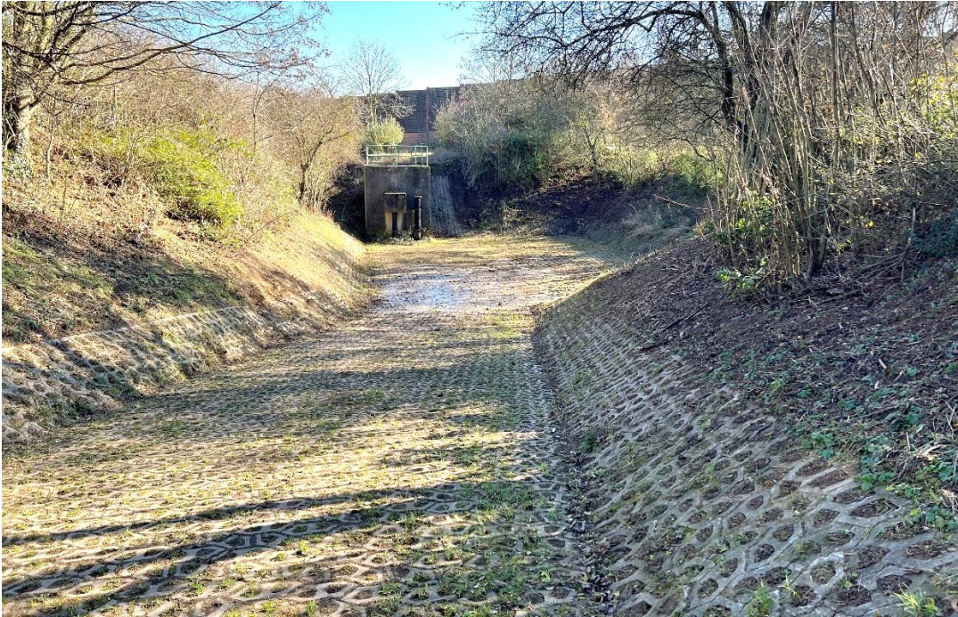
Abb.310: RRB 2 mit Mönchbauwerk
