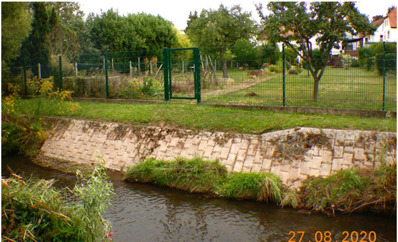
Abb. 171: Überflutungsgefährdete Bebauung am Eisbach
