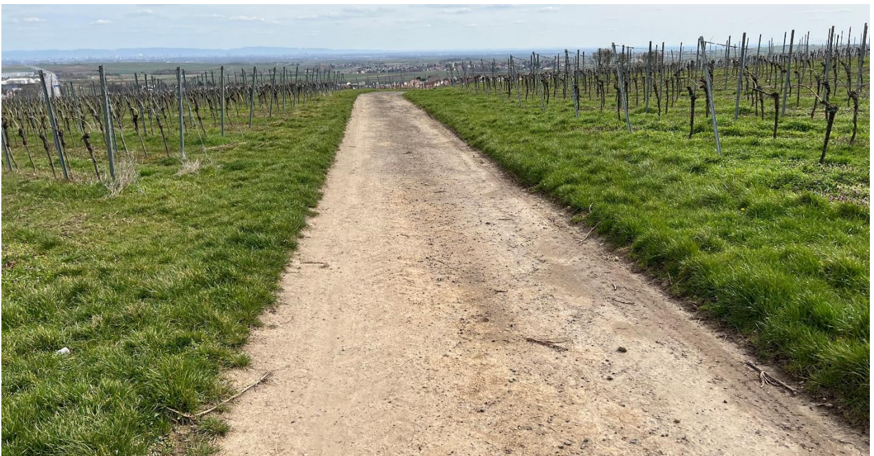
Abb. 276: Unbefestigter Weg als Abfanggraben für Außengebietswasser
