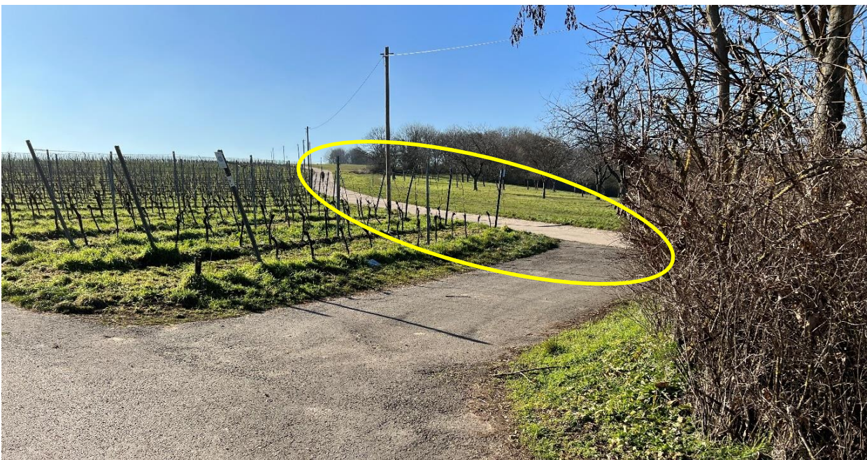
Abb. 185: Weg mit Potenzial zur Querentwässerung (gelbe Markierung) und Abzweig Mittelpfad
