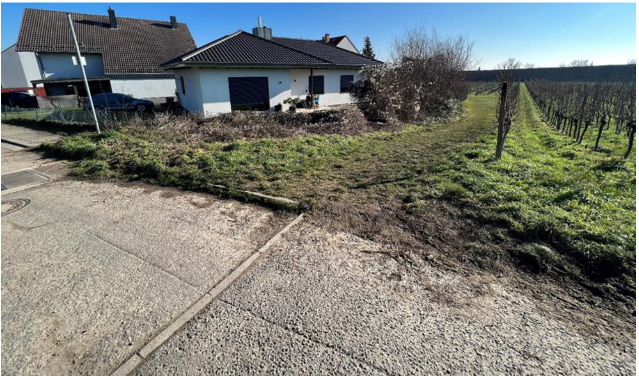
Abb. 231: Potenziell überflutungsgefährdetes Gebäude am Bauungsrand Hochgewanne
