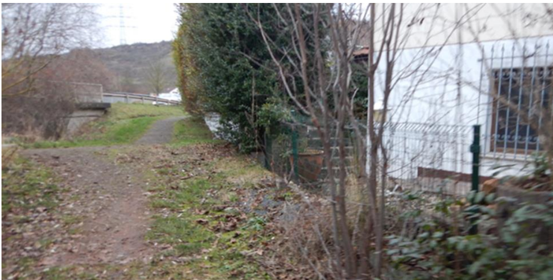
Abb. 161: Extrem überflutungsgefährdetes Wohngebäude am Eisbach
