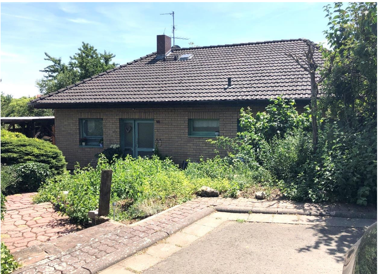
Abb. 150: Überflutungsgefährdete Bebauung im Wohngebiet „Auf der Setz“
