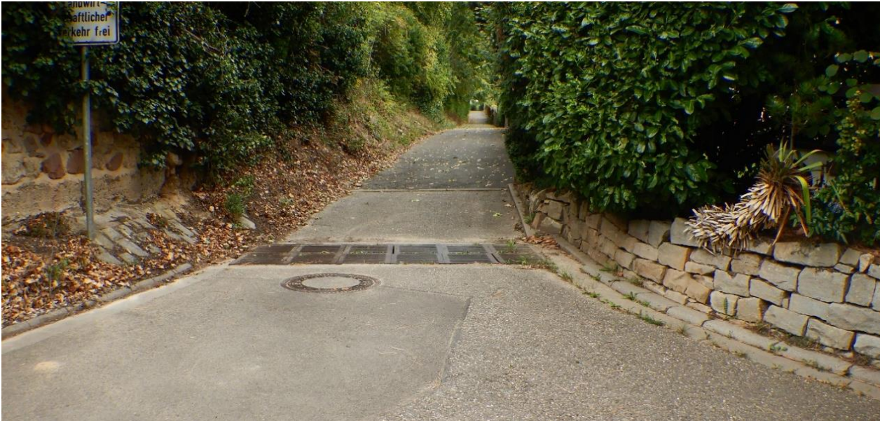
Abb. 213: Weg mit Querrinne oberhalb der Bebauung Tiefenthaler Straße und „In der Röth“
