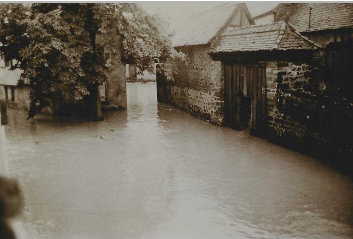
Abb. 167: Eisbachhochwasser im tiefliegenden Ortskern 1997, Foto: Schott
