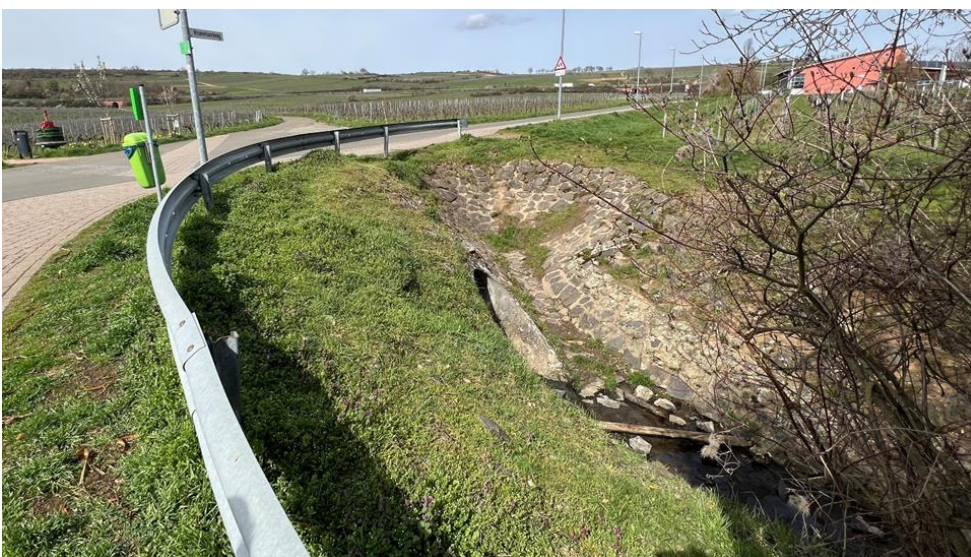
Abb. 284: Ausmündung des Regenwasserkanals vom Autobahndurchlass in den Zulaufgraben zum RRB 5
