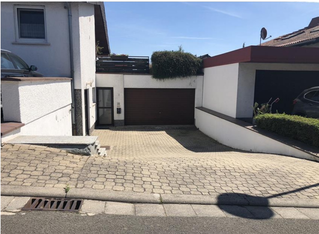
Abb. 34: Überflutungsgefährdete Eingangstüren und Garage
