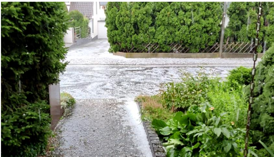
Abb. 327: Überflutung Brückelweg im August 2021, Foto: Höhn
