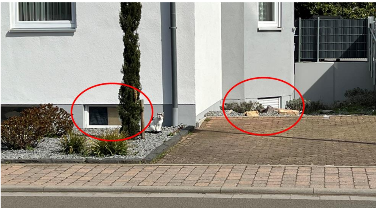
Abb. 258: Potenziell Überflutungsgefährdete in der südlichen Bärenbrunnenstraße
