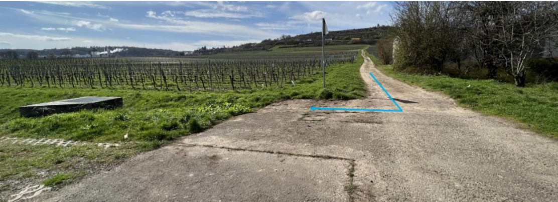
Abb. 268: Zulaufmulde vom Wasenweg in das „Regenrückhaltebecken“
