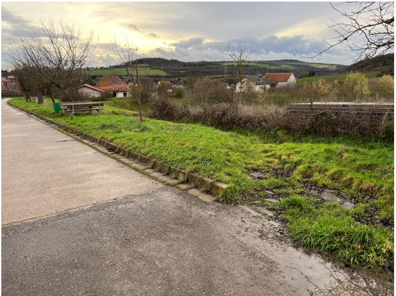
Abb. 122: Furt zur Querentwässerung des Weges am Friedhof
