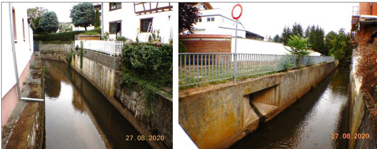
Abb. 15: Eisbach oberhalb (oben) und unterhalb (unten) der Brücke Langgasse
