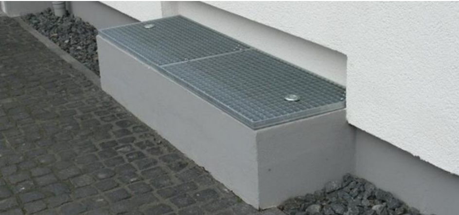
Abb. 37: Beispiel für die Sicherung eines niveaugleichen Lichtschachtes
