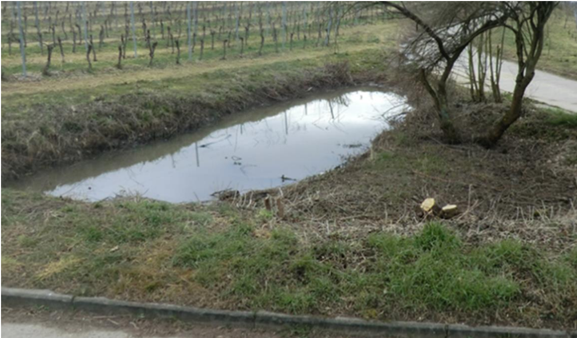
Abb. 23: Beispiel für einen Kleinrückhalt neben Wegen
