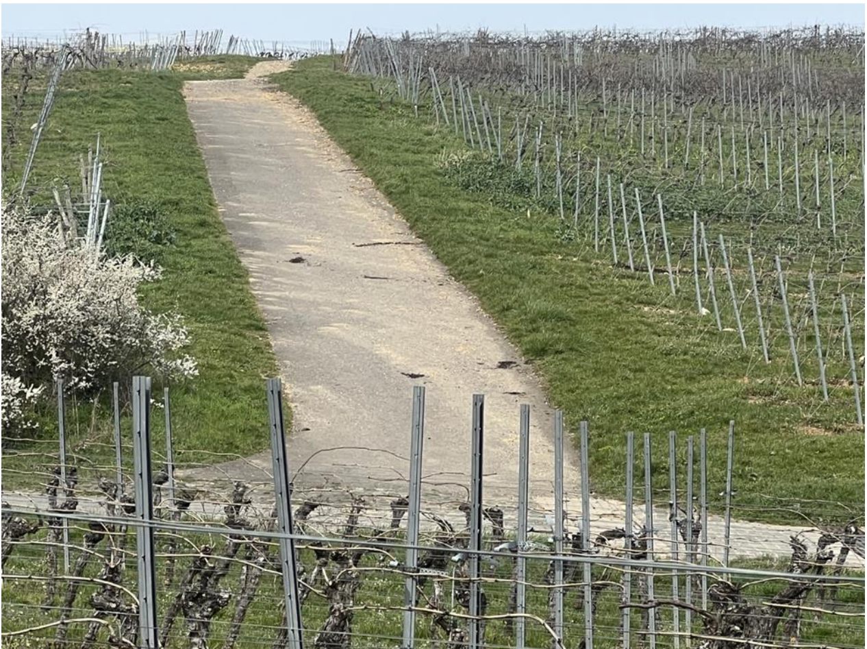
Abb. 298: Beispiele für steile, wasserführende Wege im Einzugsgebiet Krummlandweg
