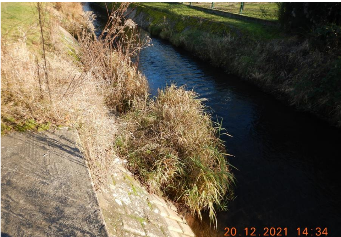
Abb. 170: Massiv ausgebauter Eisbach unterhalb der Langgasse
