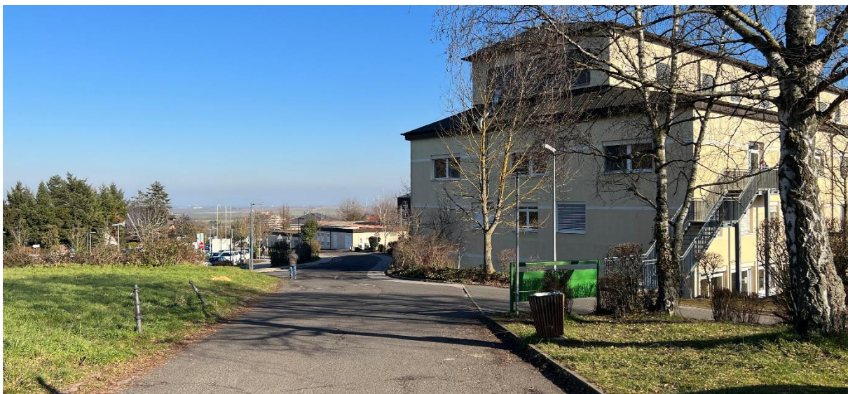
Abb. 197: Straße „Am Bergel“ mit Trafostation als potenzieller Notabflussweg
