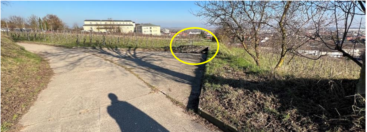
Abb. 189: Abflussweg von Süden in das RRB, Standort Sandfang (gelbe Markierung)
