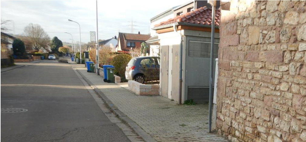
Abb. 84: Potenziell überflutungsgefährdete Trafostation im östlichen Auweg
