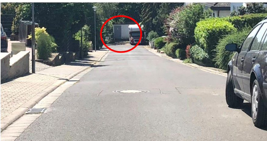
Abb. 5: Beispiel für eine Trafostation am Ende einer abschüssigen Straße
