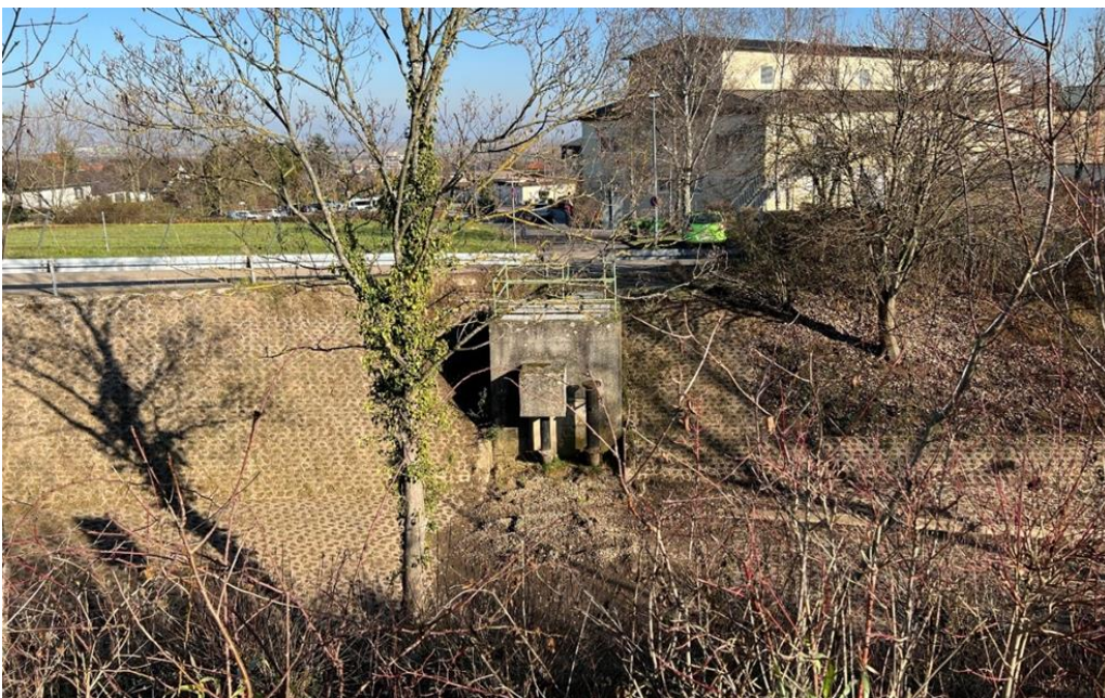
Abb. 188: Regenrückhaltebecken (RRB) mit Zulauftrinne, querendem Steg (Bild oben) und Mönchbauwerk mit Hochwasserentlastung (Bild unten)
