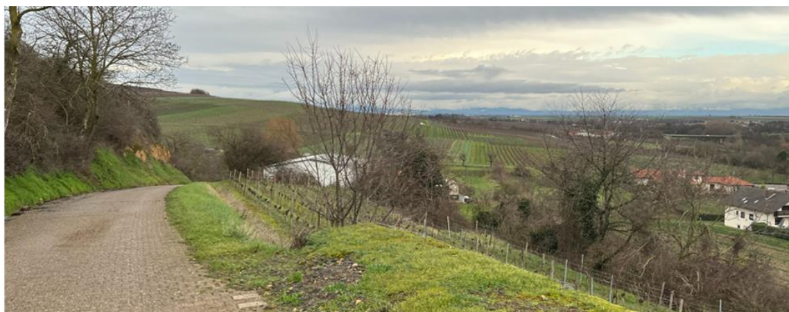
Abb. 128: Zuflusswege zum oberen Regenrückhaltebecken, Foto oben: Höveken-Haaß
