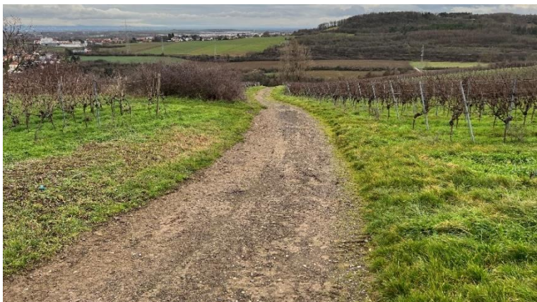
Abb. 30: Wegstrecke mit geplanter Verfestigung und Anpassung der Querneigung nach Westen
