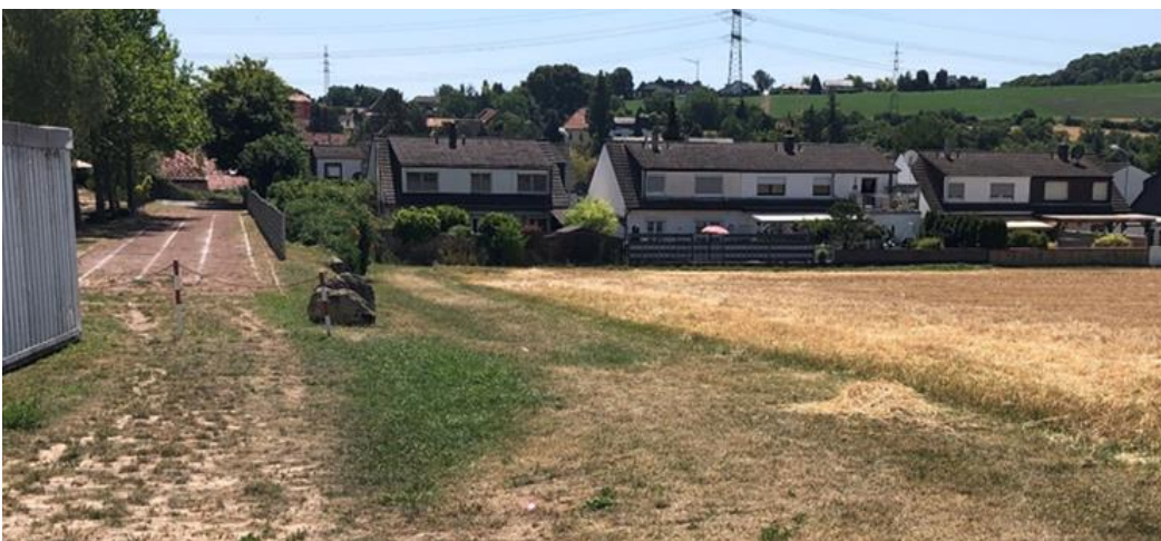
Abb. 95: Ungesicherte Zuwegung zum Sportgelände, zur Kita und zur Auwegsiedlung
