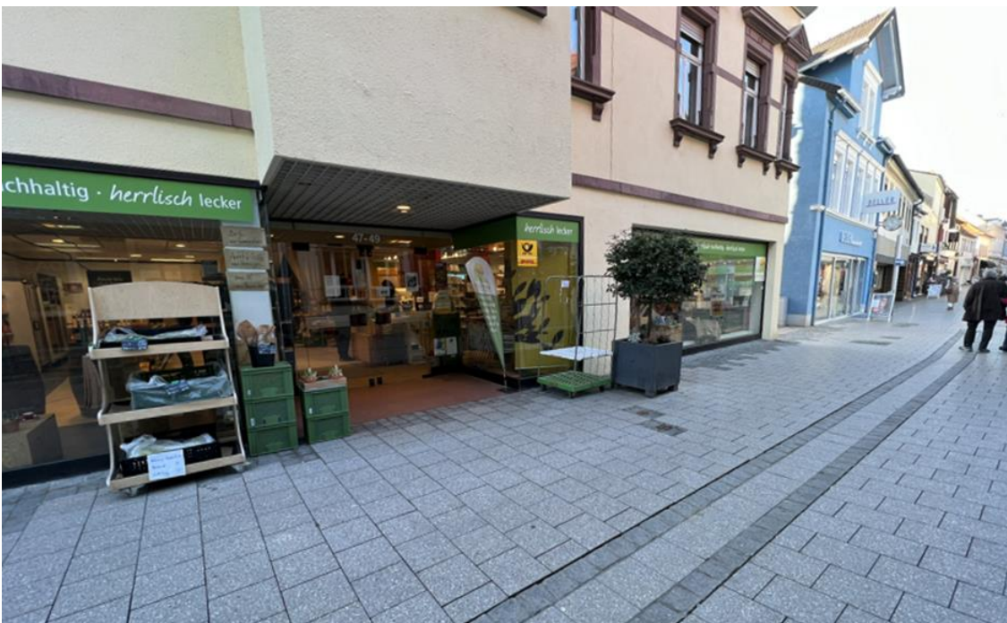
Abb. 249: Überflutungsgefährdete Geschäfte in der Fußgängerzone
