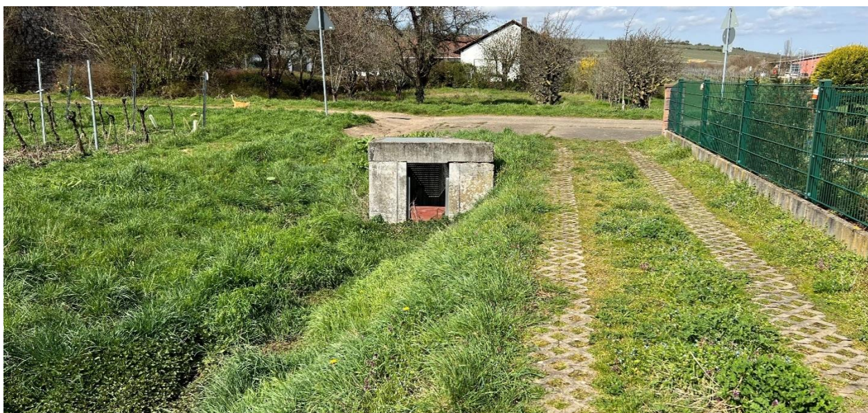
Abb. 270: Ablaufbauwerk im „Regenrückhaltebecken Bärenbrunnenstraße“
