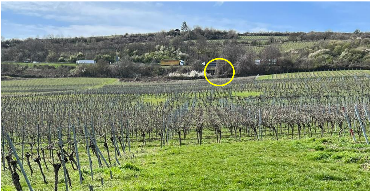
Abb. 261: Autobahndurchlass (gelb) und Einzugsgebiet östlich der Autobahn
