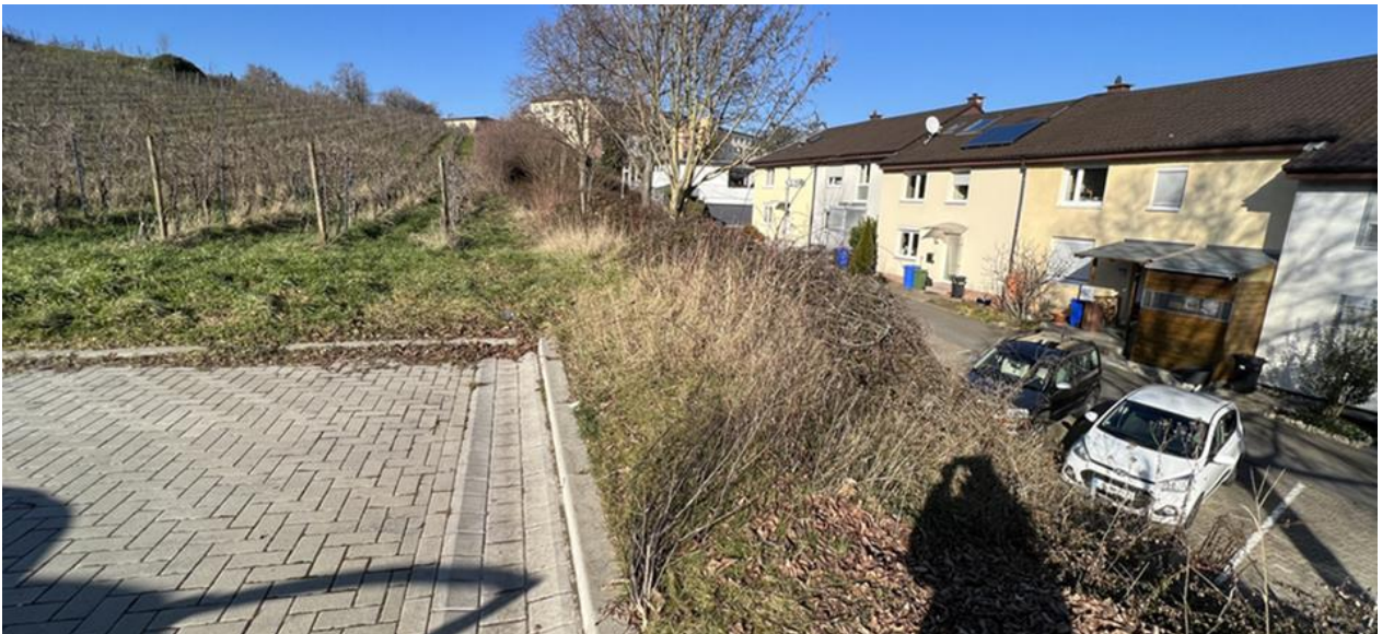
Abb. 203: Hang oberhalb der Straße „Am Wehrhaus“ (Bilder oben) und Westring (Bild unten)
