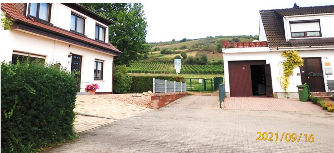
Abb. 73: Potenzieller Abflussweg durch Bebauungslücke auf den Amselweg
