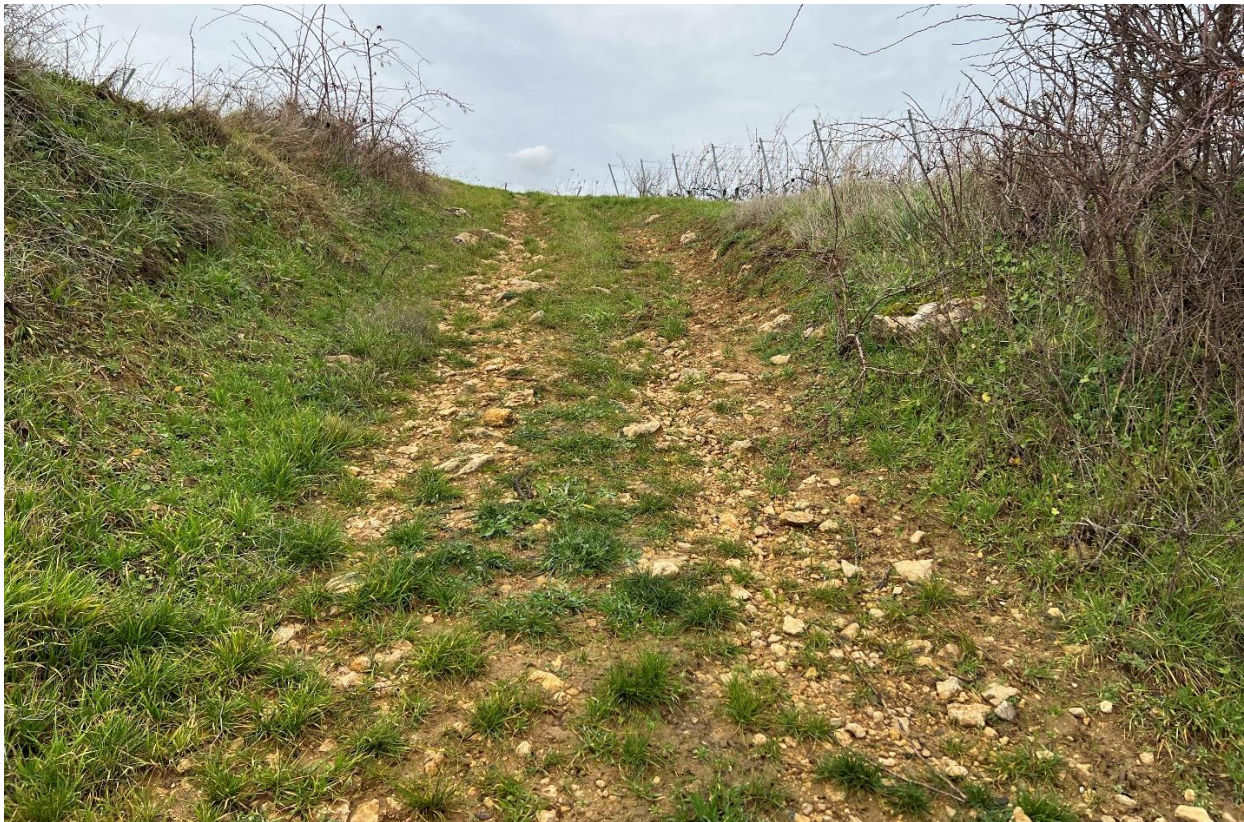
Abb. 99: Unbefestigter Weg in Falllinie auf den Neuweg
