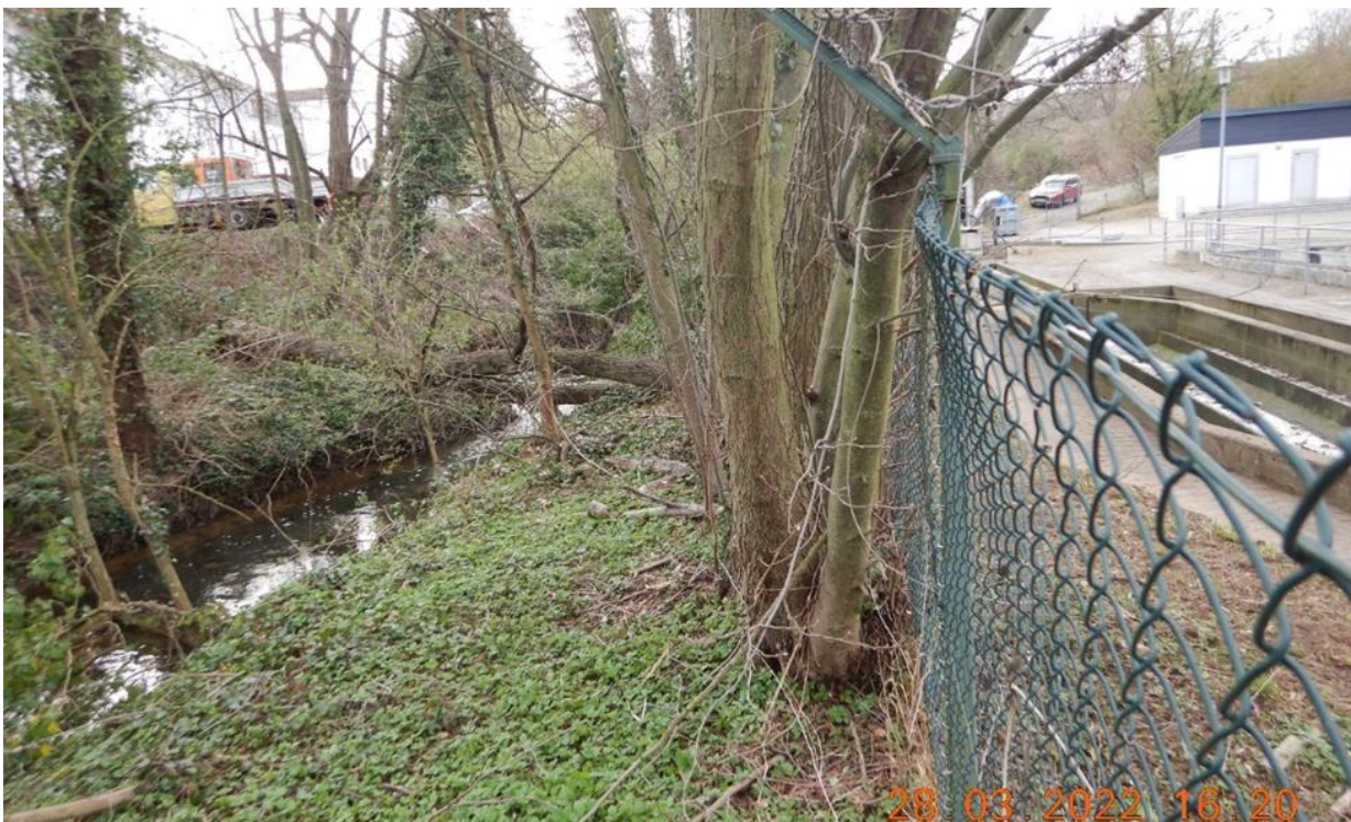
Abb. 12: Totholz im Bachbett des Eisbach als potenzielles Abflusshindernis neben der Pumpstation Asselheim - Konflikt zwischen Ökologie und Objektschutz
