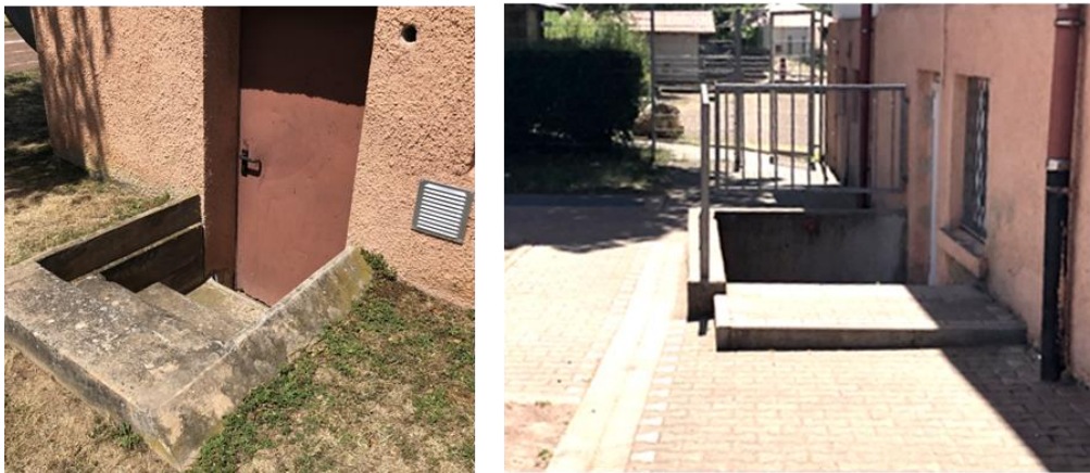
Abb. 96: Schwellen an außenliegenden Treppenabgängen
