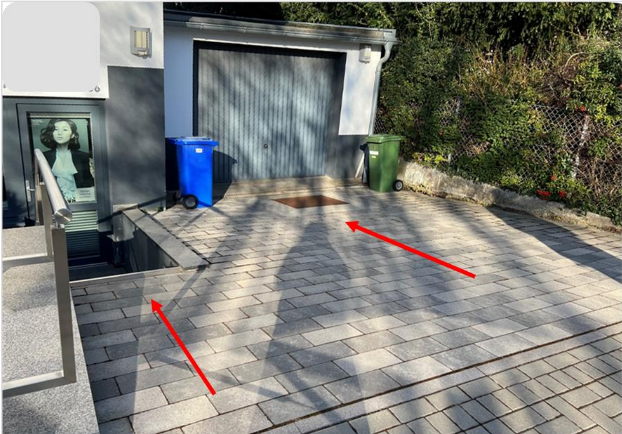
Abb. 243: Überflutungsgefährdete Garage unter dem Niveau der Haydnstraße
