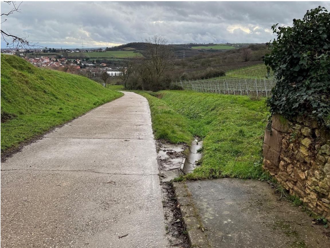
Abb. 117: Beginn des Kützelsborngrabens am alten Friedhof
