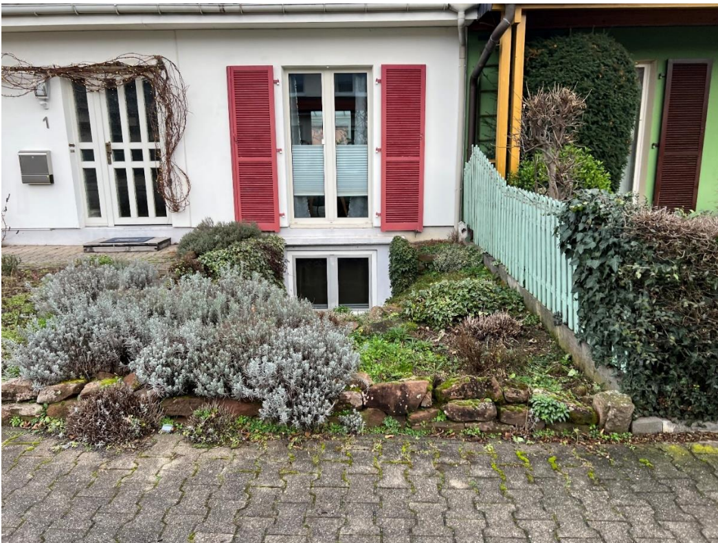
Abb. 78: Überflutungsgefährdete Bebauung in der Auwegsiedlung
