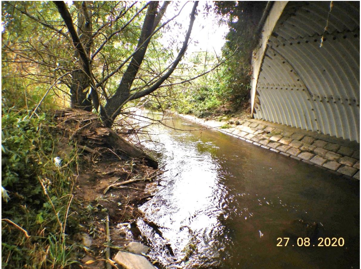
Abb. 158: Leistungsfähige Brücke der L 395 über den Eisbach
