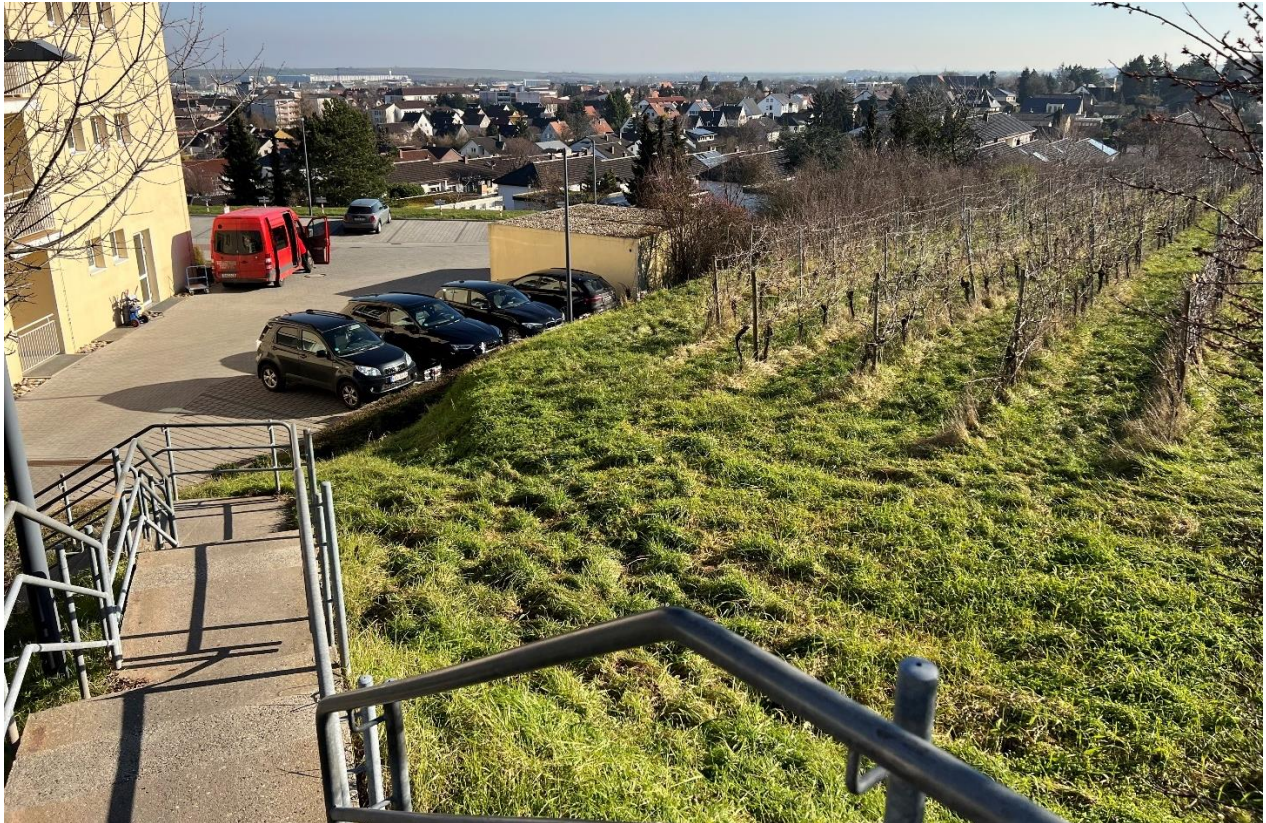
Abb. 193: Potenzielle Zuflusswege für Außengebietswasser zum tiefliegenden Kreiskrankenhaus
