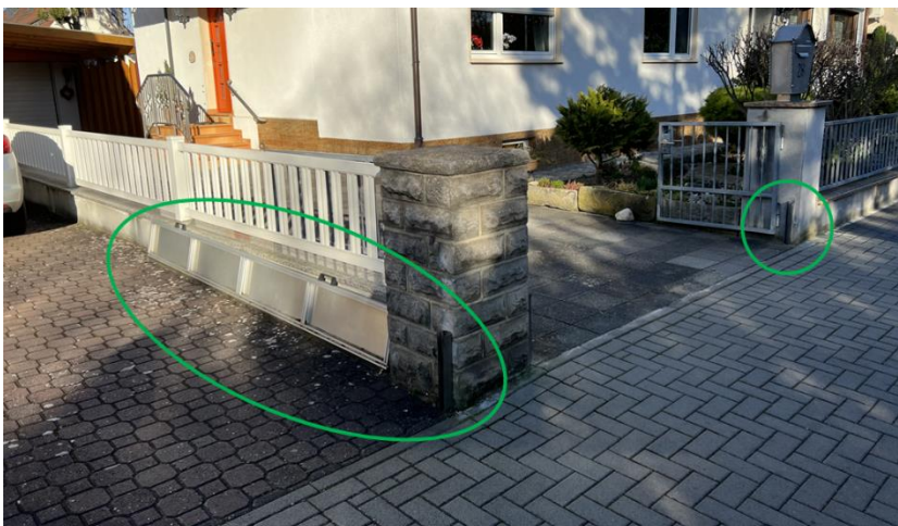
Abb. 242: Bestehender Objektschutz in der Haydnstraße
