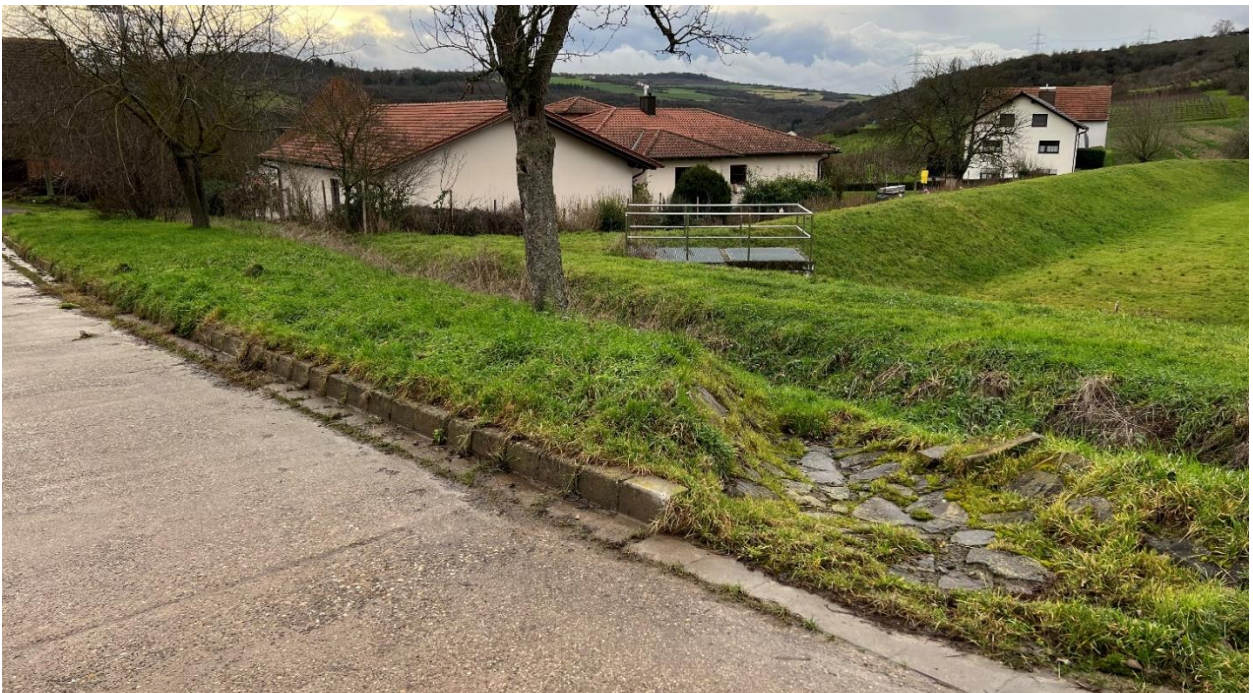
Abb. 124: Kützelsborngraben am unteren Regenrückhaltebecken mit Abschlagsrinne vom Weg
