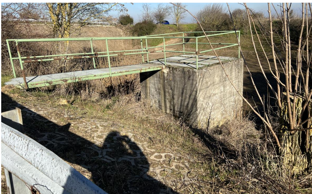
Abb. 209: Regenrückhaltebecken mit Mönchbauwerk im Februar 2023
