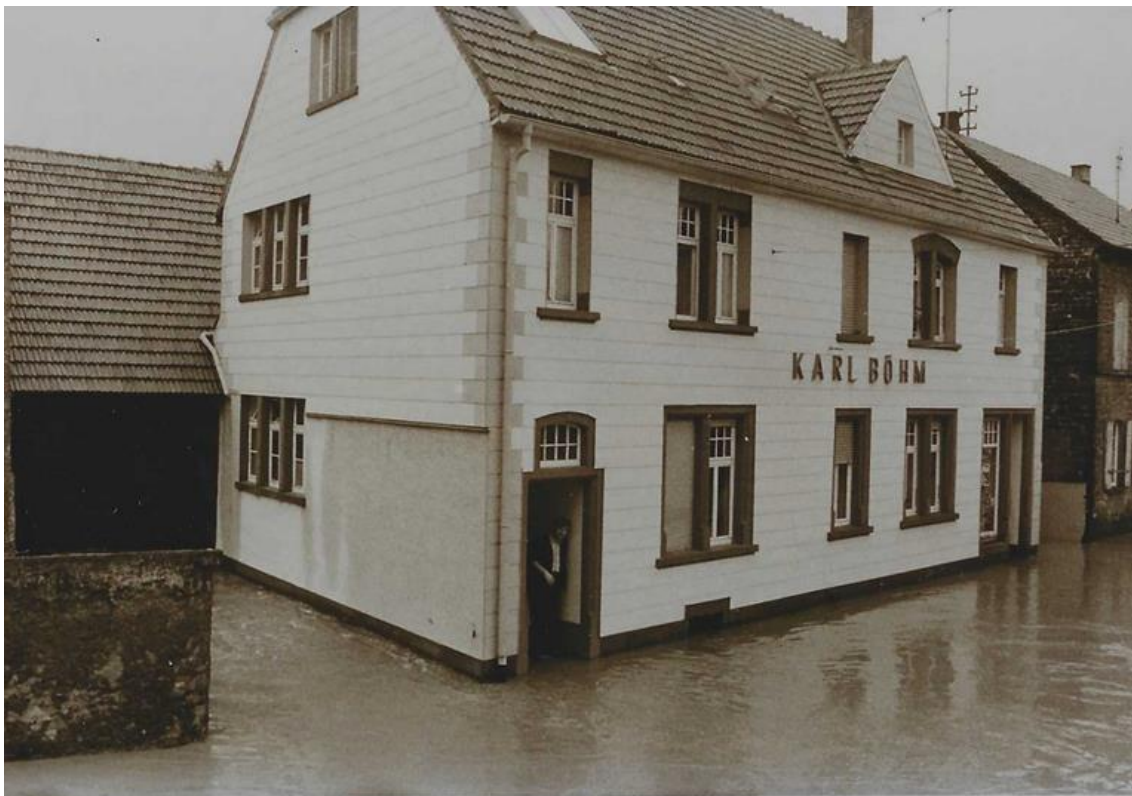
Abb. 166: Eisbachhochwasser im Tiefpunkt der Langgasse 1997, Foto: Schott
