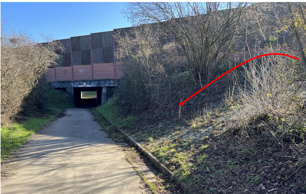
Abb. 311: Kohlstraße als Notwasserweg für die Hochwasserentlastung des RRB 2
