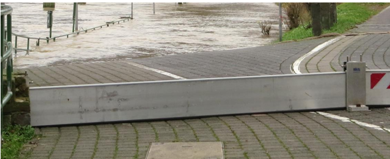
Abb. 136: Beispiel für mobile Umlenkeinrichtung für Sturzfluten
