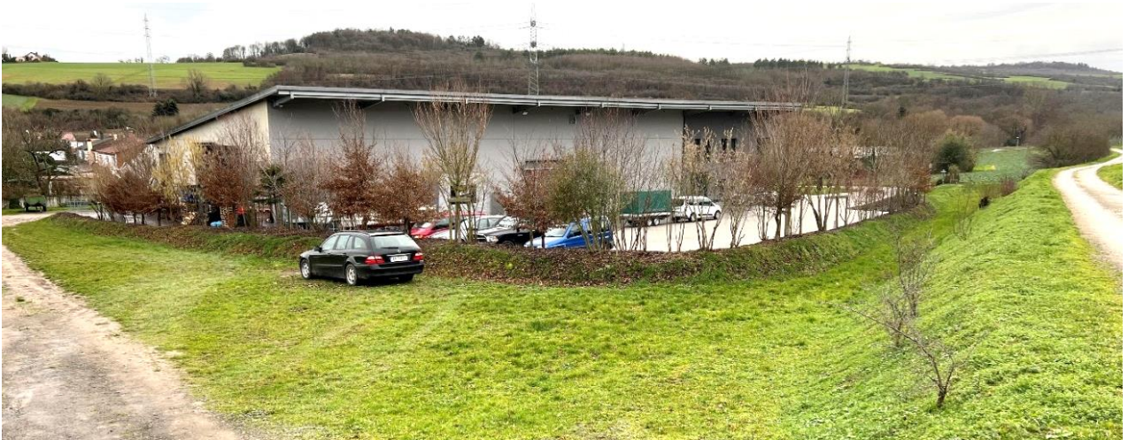
Abb. 60: Verwallung am Weingut als Objektschutzmaßnahme und Graben am Römerweg
