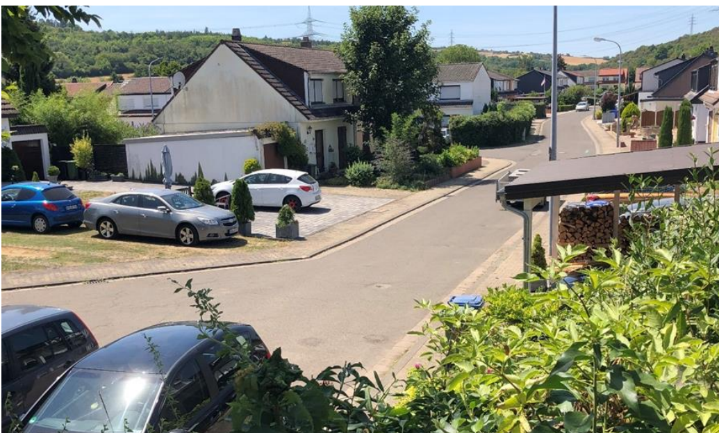
Abb. 83: Überflutungsgefährdete Bebauung in der Auwegsiedlung
