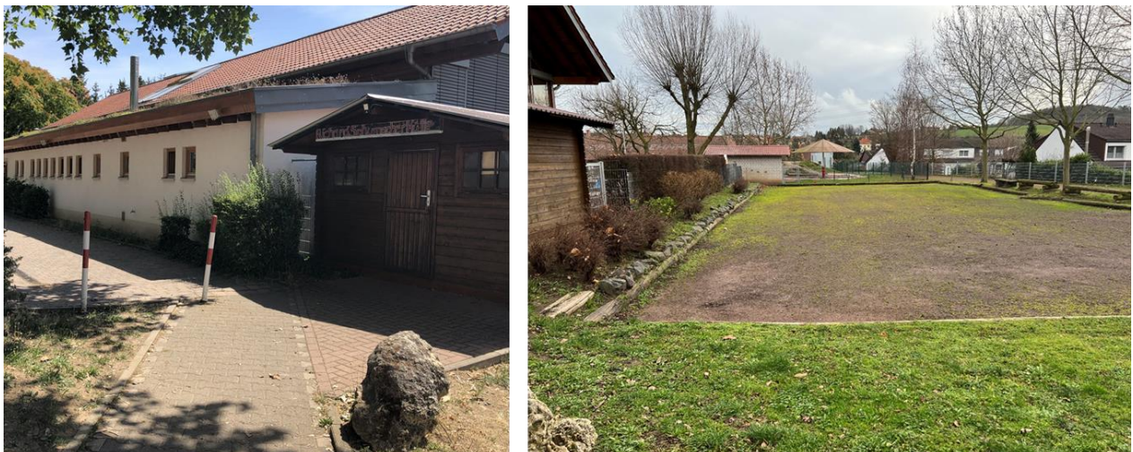
Abb. 93: Von der Turnhalle her überflutungsgefährdetes Gelände
