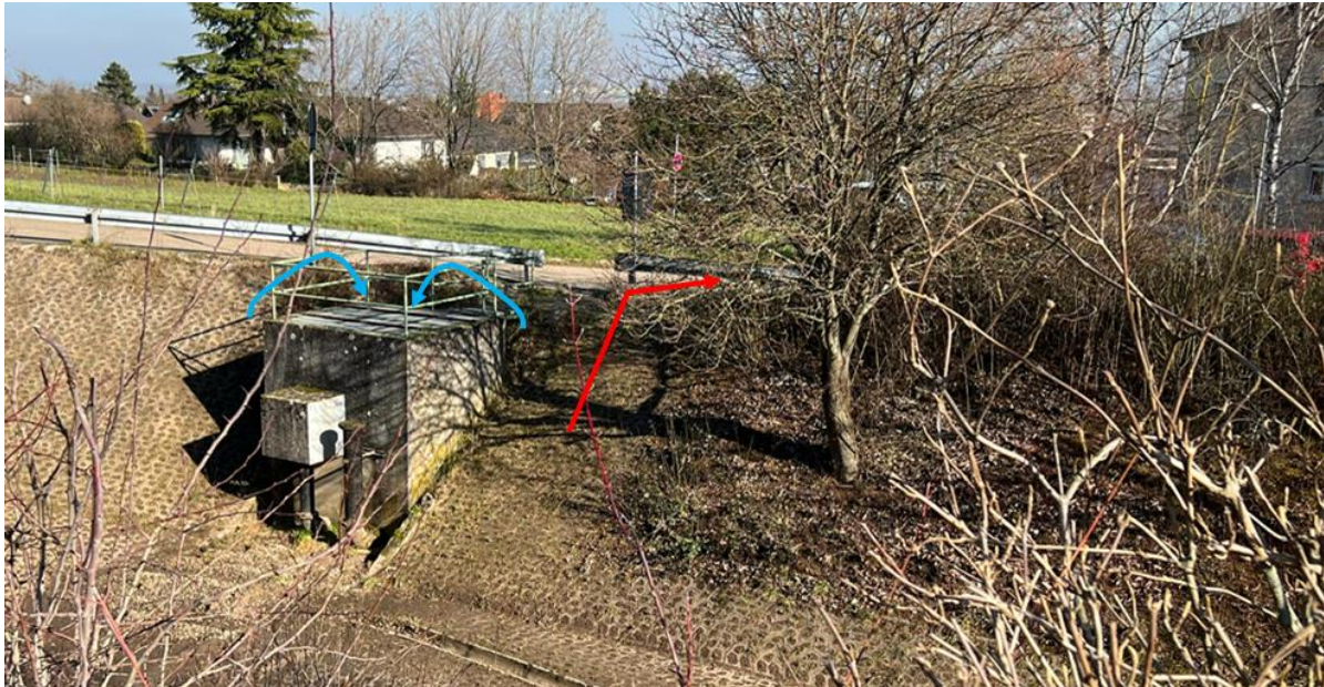
Abb. 196: Hochwasserentlastung (blaue Pfeile) und Notentlastung (roter Pfeil)
