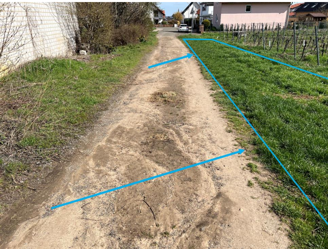
Abb. 269: Wasenweg mit Vorschlag zum Umbau (Querentwässerung und überfahrbare Mulde in das RRB)
