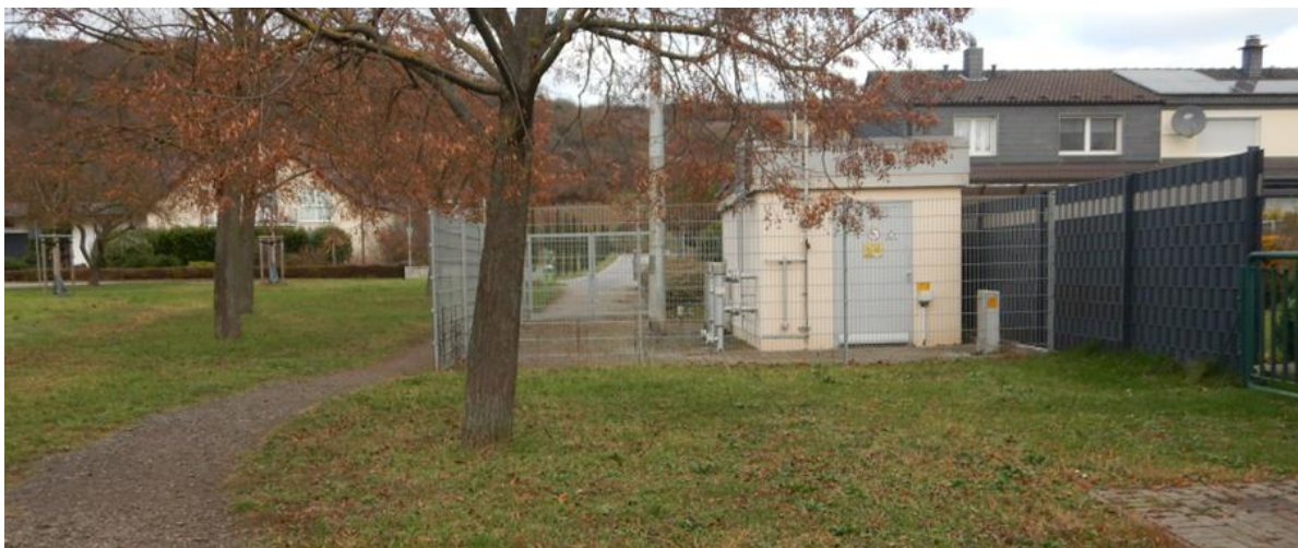
Abb. 63: Im Extremfall überflutungsgefährdete Gasstation im westlichen Auweg
