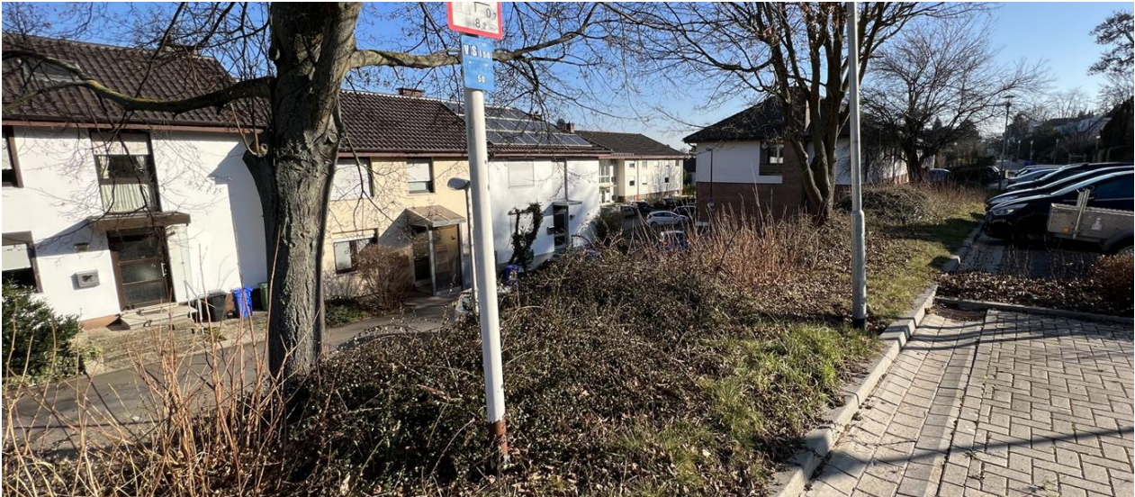
Abb. 204: Potenziell überflutungsgefährdete Bebauung in der Straße „Am Wehrhaus“ und im Westring
