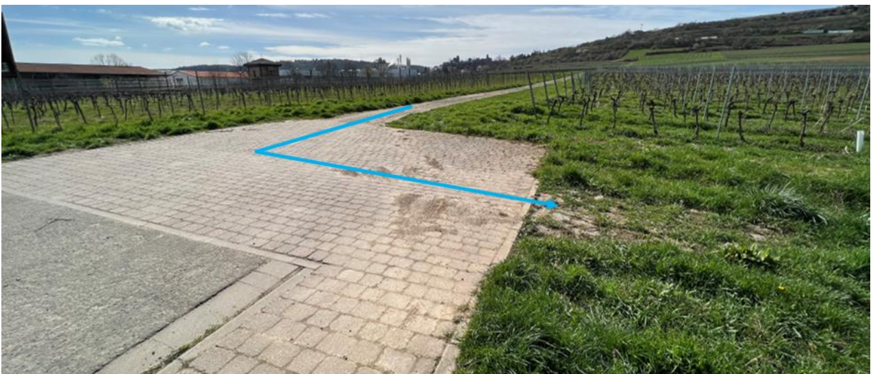
Abb. 267: Zulaufmulde an der südlichen Stirnseite des „Regenrückhaltebeckens“
