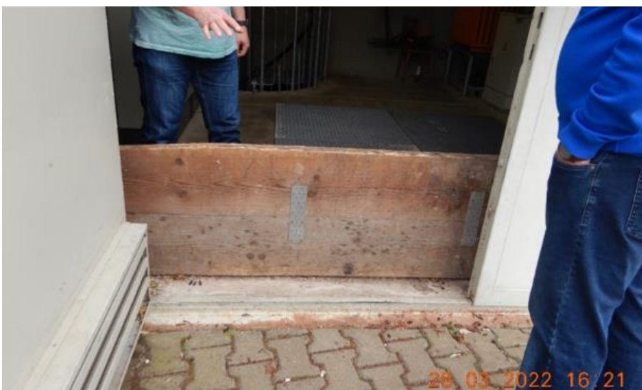
Abb. 9: Provisorischer Objektschutz auf der Pumpstation Asselheim
