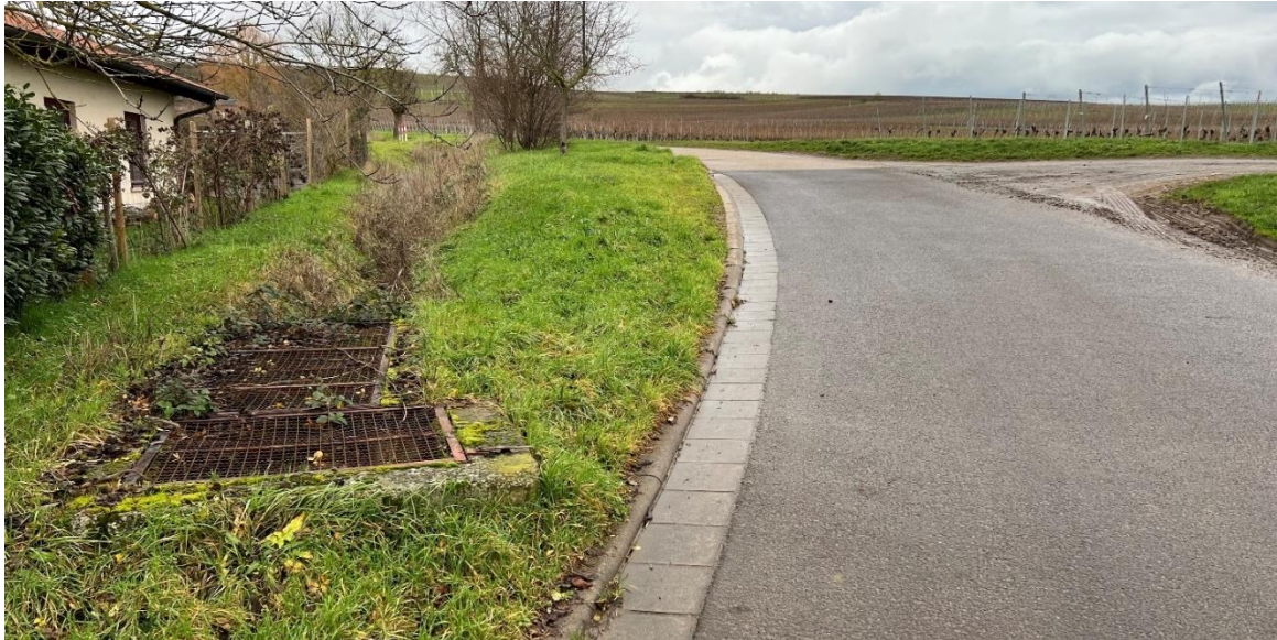
Abb. 125: Kützelsborngraben mit Sandfang zur Verrohrung
