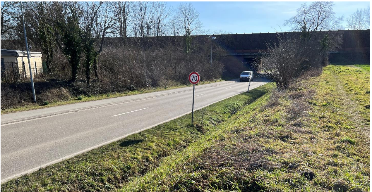
Abb. 239: Seitengraben an der L 453
