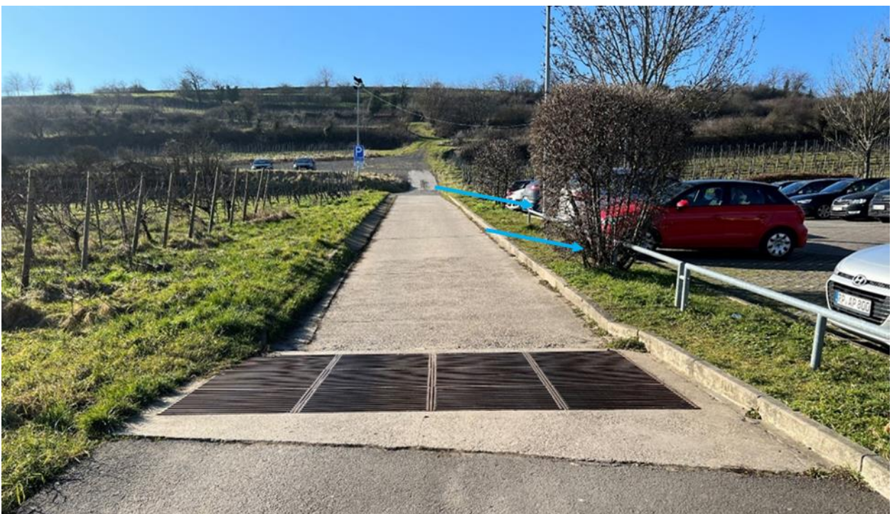
Abb. 190: Einzugsgebiet des Höllenpfads und Querrinne zum RRB
