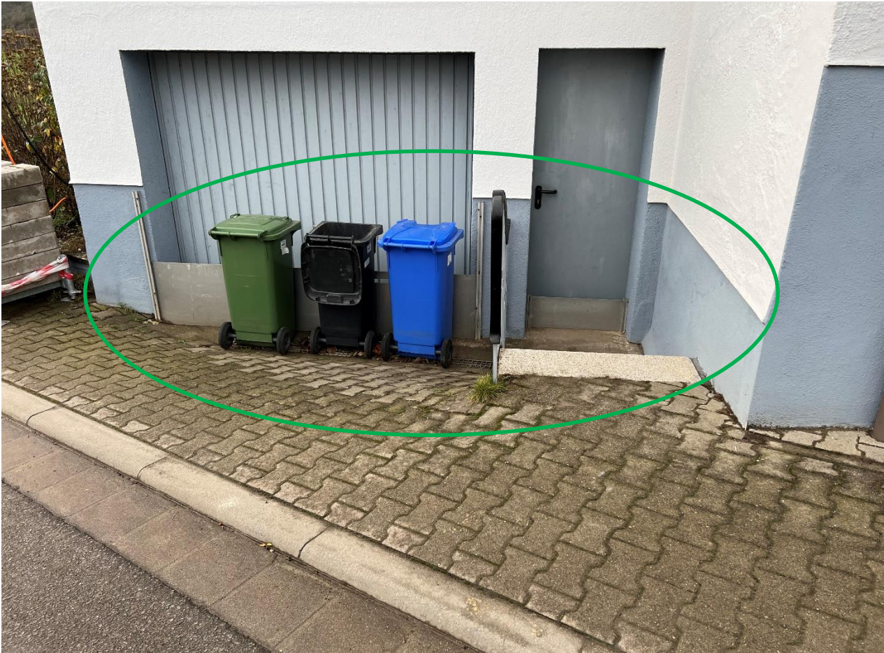
Abb. 139: Beispiel für Dammbalken zur Sicherung einer Kellertür und eines ehemaligen Garagentors unter dem Straßenniveau
