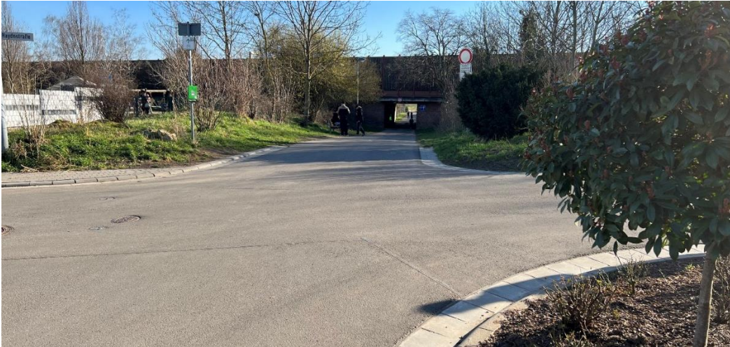
Abb. 244: Wirtschaftsweg von der Haydnstraße zum Autobahndurchlass
