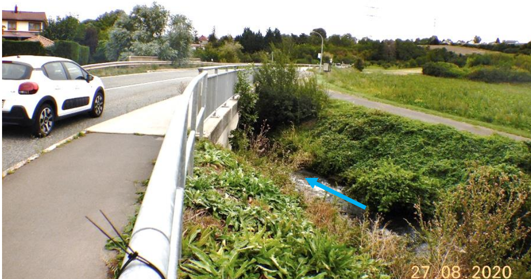
Abb. 157: Eisbach oberhalb der L 395 mit potenziellem Standort für Retentionsmaßnahme (Maßnahme 6.7-1)
