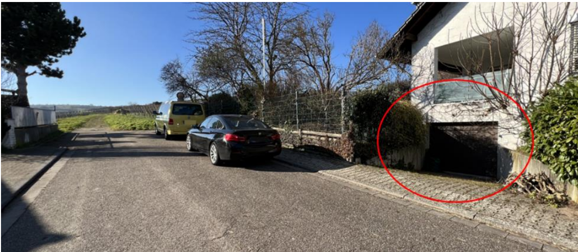
Abb. 226: Potenziell überflutungsgefährdetes Gebäude
