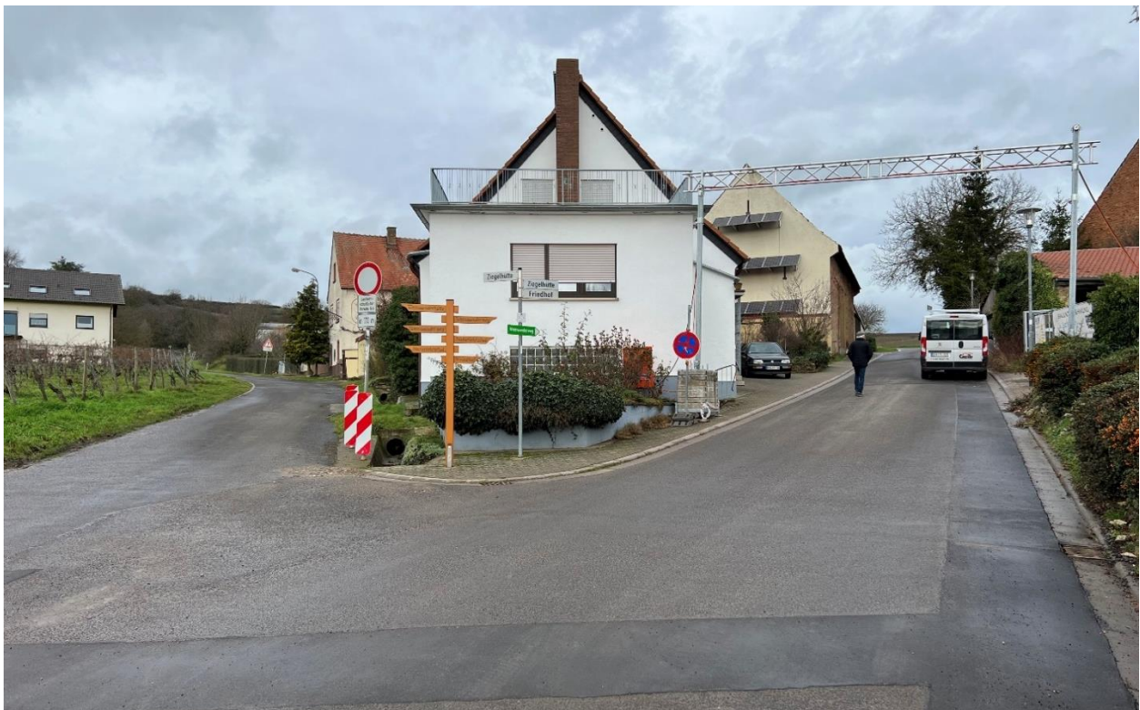
Abb. 138: Überflutungsgefährdete Bebauung im Bereich Ziegelhütte
