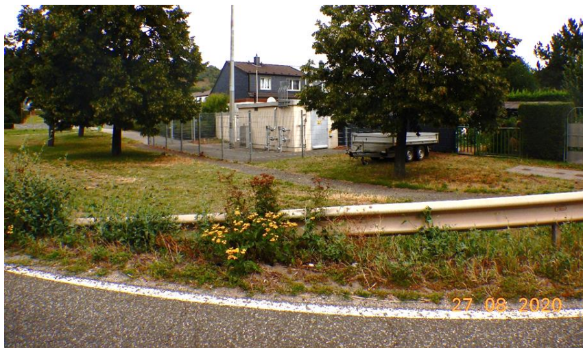
Abb. 10: Überflutungsgefährdete Gasstation in der westlichen Auwegsiedlung
