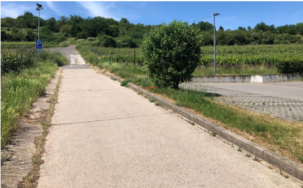
Abb. 22: Bordsteine und Aufkantungungen kanalisieren das Wasser auf dem Weg
