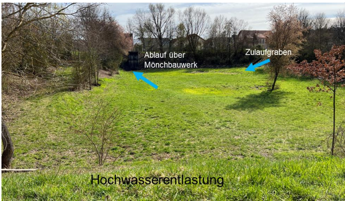
Abb. 291: Zulaufgraben und RRB 5
