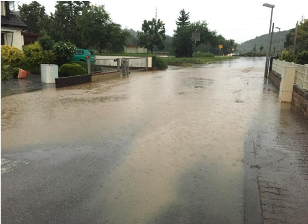
Abb. 49: Überflutung Straße „Im Auweg“ am westlichen Ortsrand, Juni 2016, Foto: NN, Stadtverwaltung
