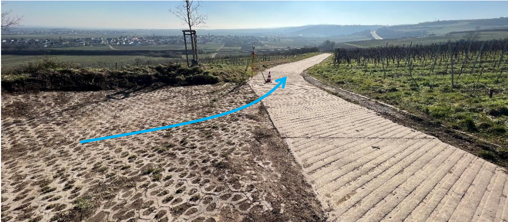
Abb. 210: Hochwasserentlastung zur Kohlstraße
