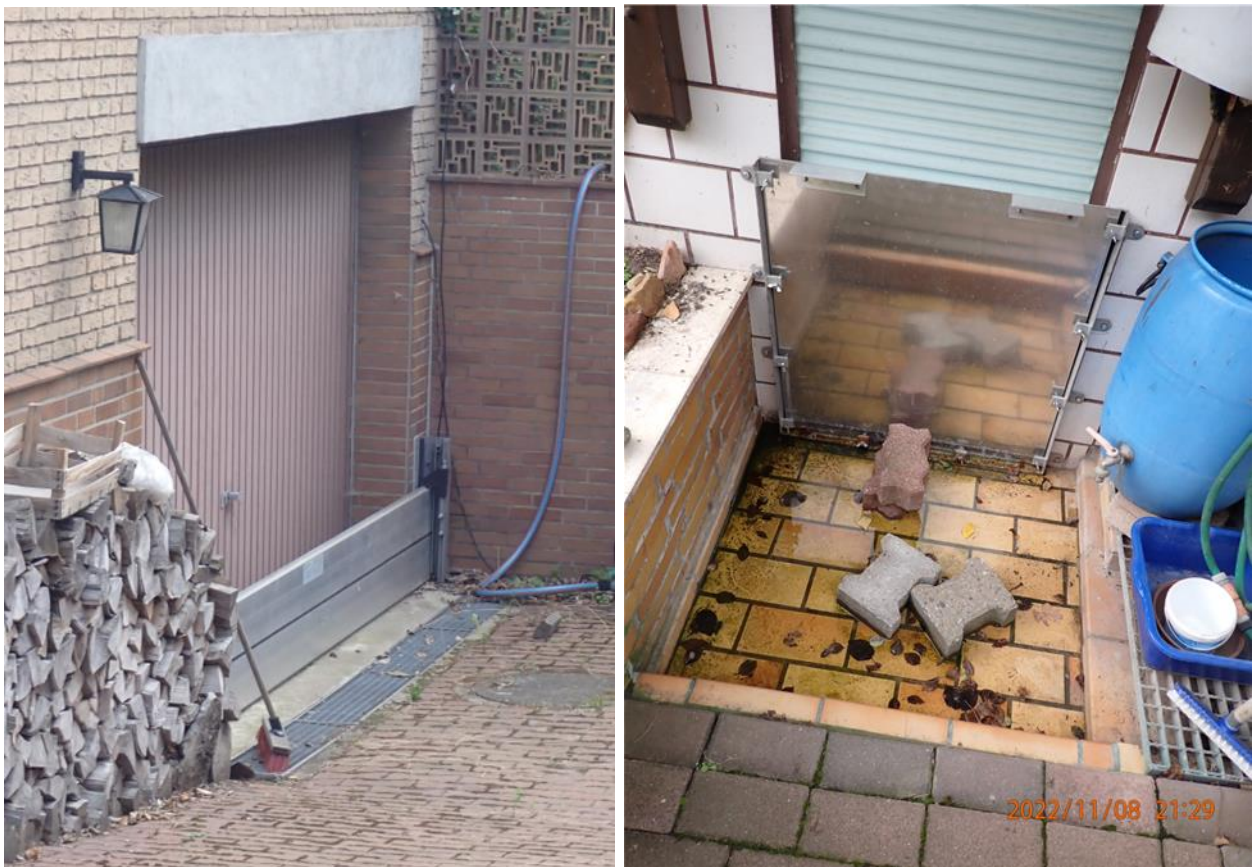
Abb. 36: Beispiele für temporäre Objektverschlüsse, links: Dammbalken, rechts: Schott
