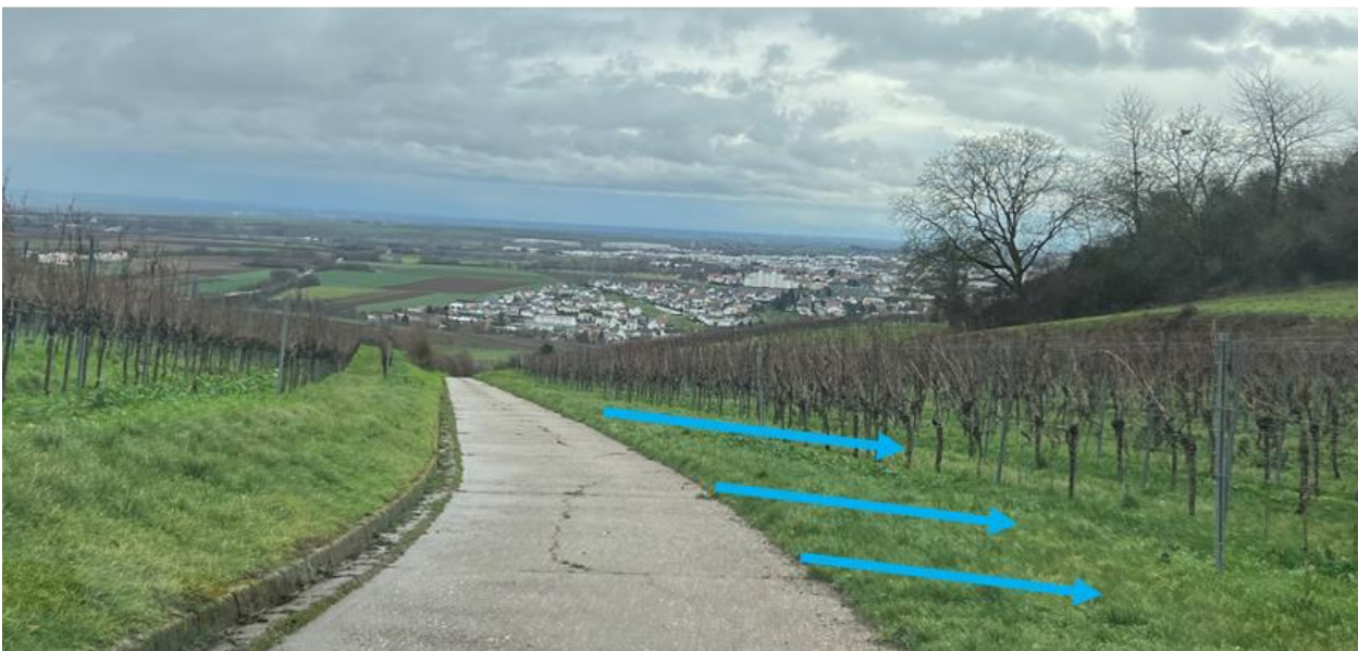
Abb. 127: Wege mit Potenzial zur Querentwässerung
