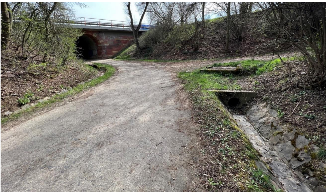
Abb. 280: Sandfänge am Ende der Seitengräben
