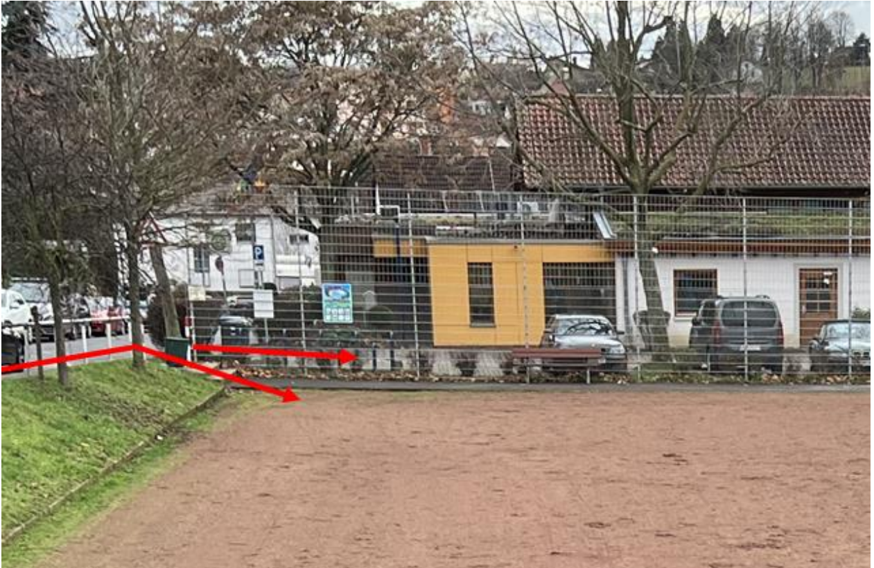
Abb. 89: Potenziell schädigende Zuflüsse von der Langgasse zur Kita
