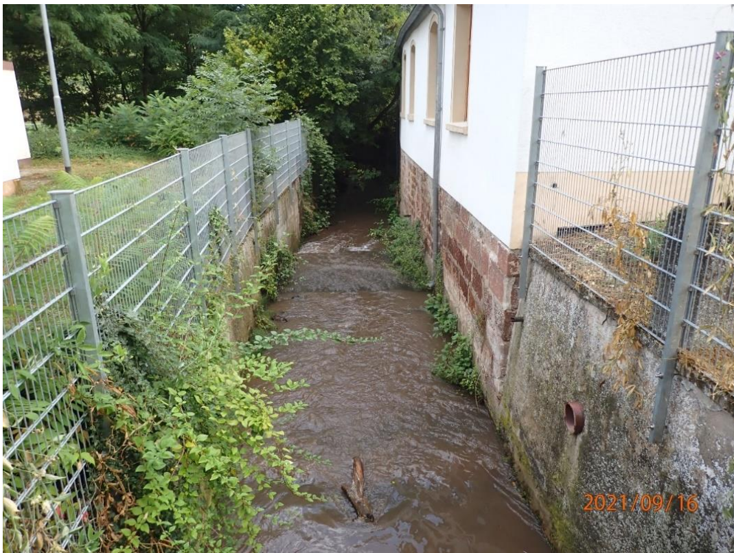
Abb. 155: Gebäude des Wasserwerks am ehemaligen Mühlgraben
