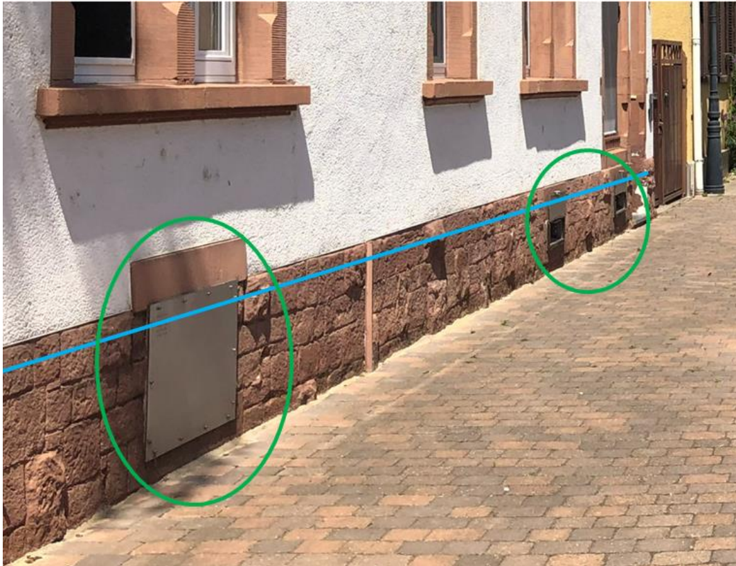
Abb. 141: Hochwasserstand 2003 (blau) und umgesetzter Objektschutz (unten) im Tiefpunkt der Langgasse
