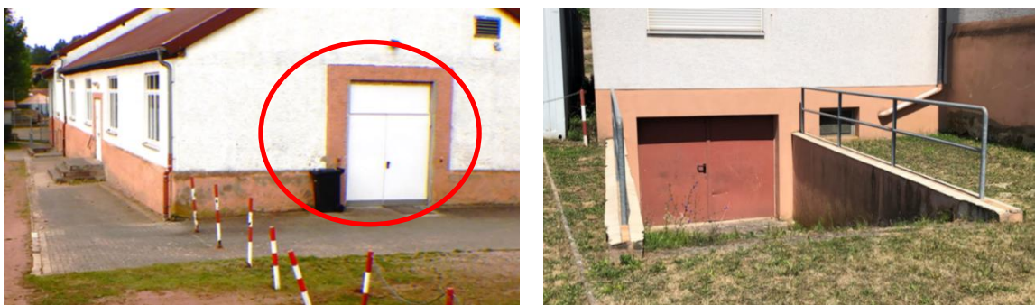
Abb. 97: Potenzielle Zutrittswege in die Turnhalle bei Sturzfluten
