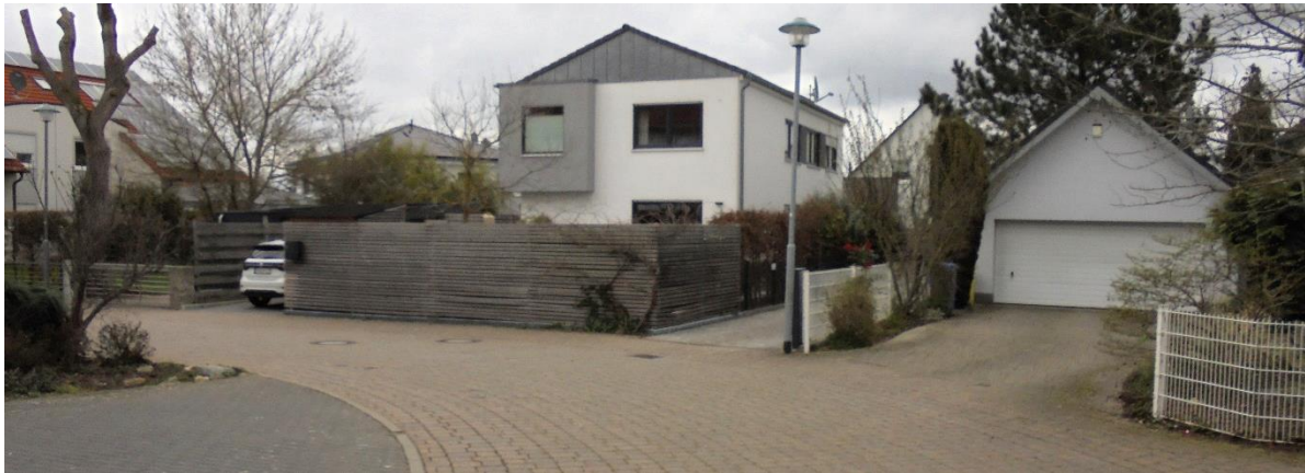
Abb. 322: Überflutungsgefährdete Bebauung im Triftweg
