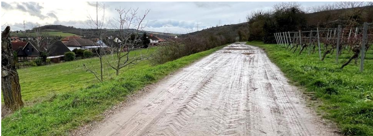
Abb. 145: Weg am Kreuz mit überflutungsgefährdeter Bebauung „Auf der Setz“
