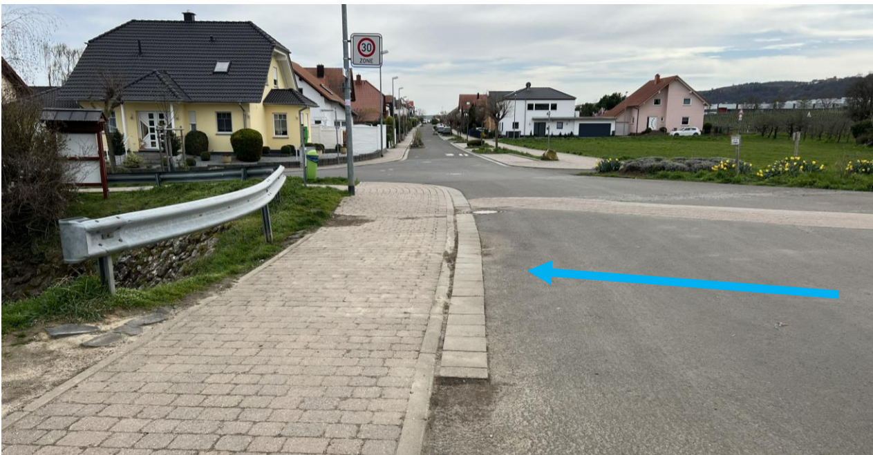
Abb. 287: Querungshilfe für Sturzfluten im Krummlandweg
